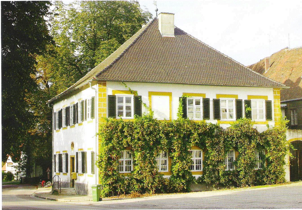
Gebäude des ehemaligen Hofmarksgerichts in Niederarnbach, Landkreis Neuburg-Schrobenhausen.
